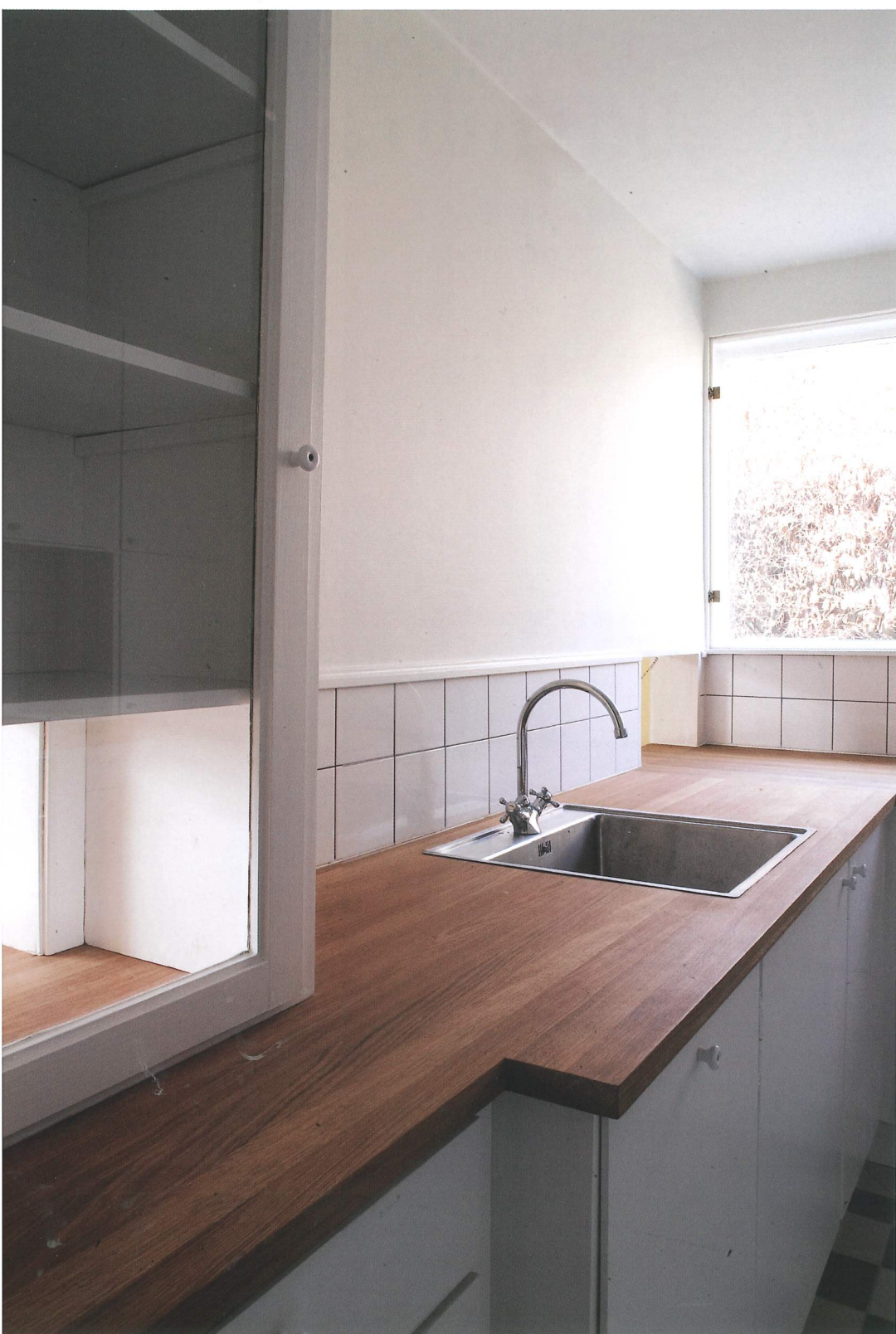
Køkkenet i Edvard Heibergs eget hus. Fra et vitrineskab til venstre for vasken kan det rene service hentes direkte via en lem til servering ved spisepladsen og sættes på spisebordet i stuen. Gennem lemmen til højre kan det beskidte service sættes tilbage på køkkenbordet.
